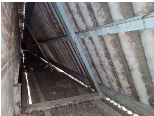
Vista interior del voladís. Detall de l'estructura metàl·lica de subjecció.
