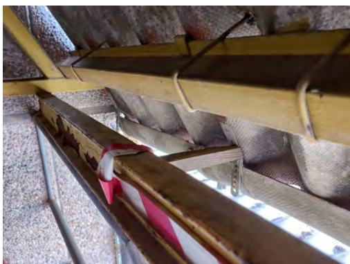
Vista interior del voladís. Detall de l'estructura metàl·lica de subjecció.
